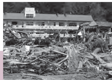
3階まで浸水してしまった高田高校の校舎。（写真／時事）
