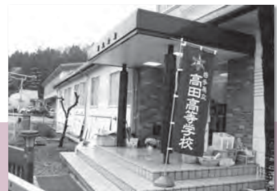
水没し、破壊された校舎から、教師がのぼりを探し出し、校門の代わりに立てている。
